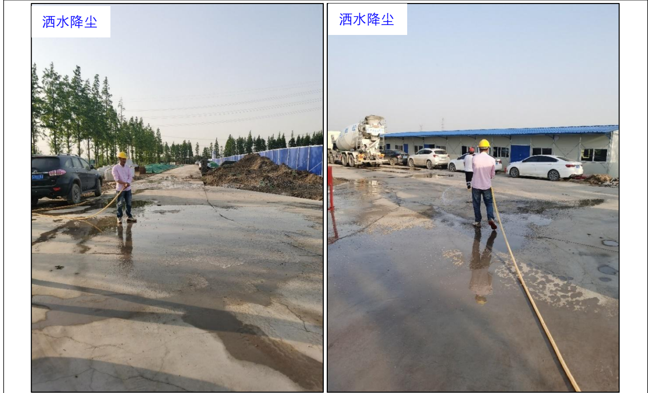
图6-1 施工期环保措施照片
