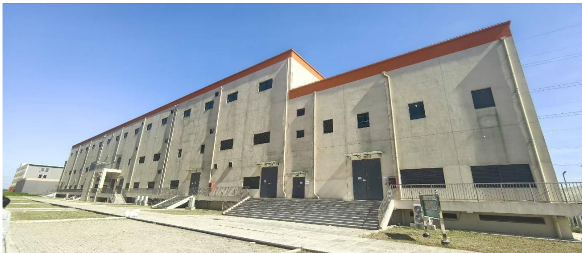
户内式变电站
