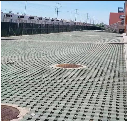
站内道路硬化
