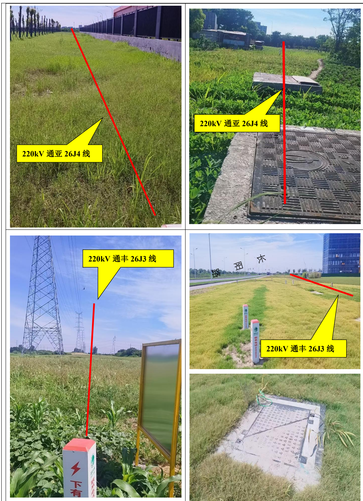
图6-3 运行期电缆工作井、电缆通道周围生态恢复措施
